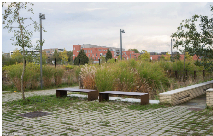
Pavés drainants enherbés.
