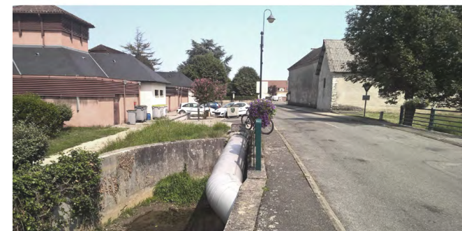
Vue de l'état existant.
