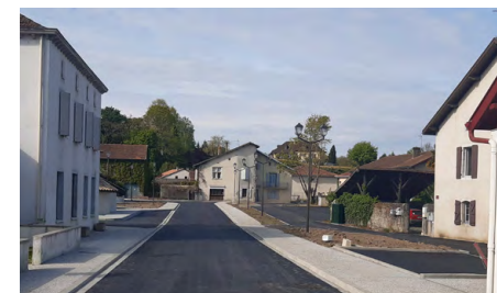
Travaux réalisés par la CCLO. © Bellocq
