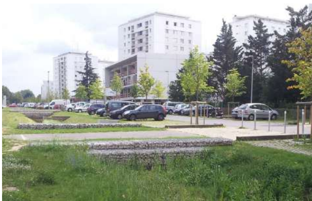
La grande noue de stockage dans l'axe du Tapis Vert.
