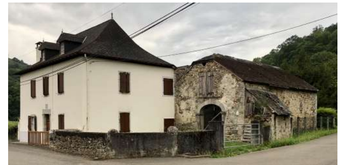
Avant travaux. Un bâtiment agricole très dégradé.
