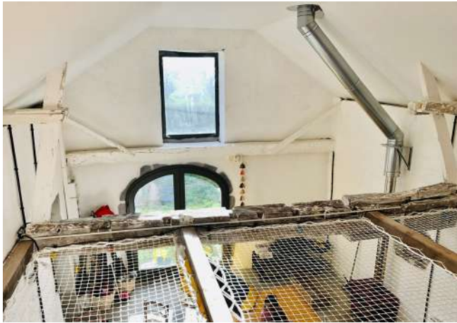
Filets dans le prolongement de la mezzanine.
