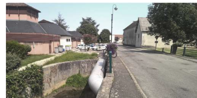
Vue de l'état existant.
