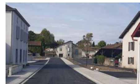
Travaux réalisés par la CCLO. © Bellocq
