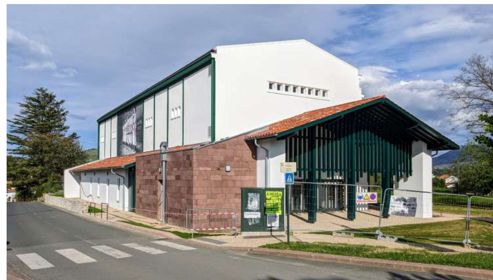
Vue du projet réalisé
