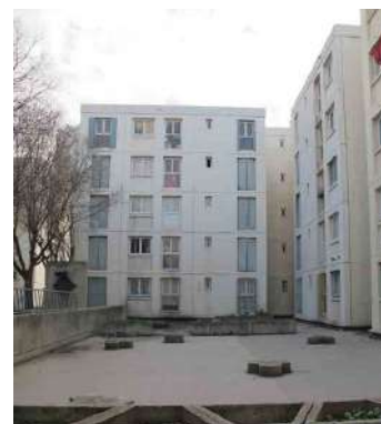
Vues des bâtiments existants.
