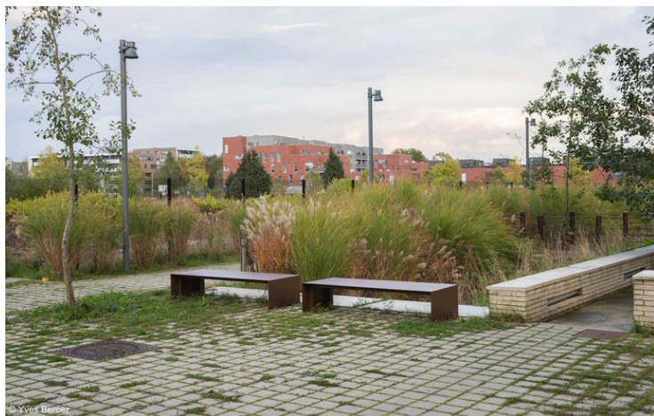
Pavés drainants enherbés.
