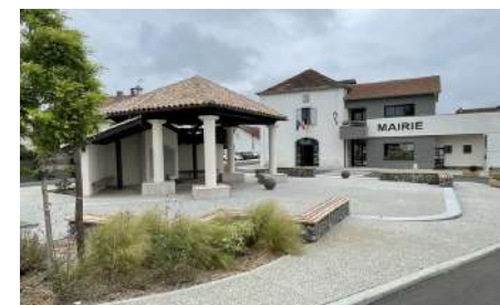
Travaux réalisés par la CCLO. © Bellocq
