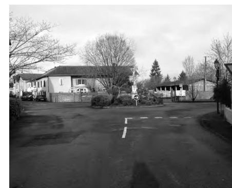
Etat avant travaux.
