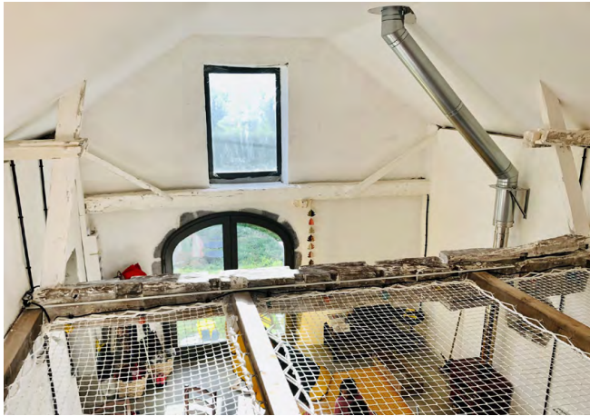
Filets dans le prolongement de la mezzanine.
