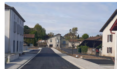
Travaux réalisés par la CCLO. © Bellocq
