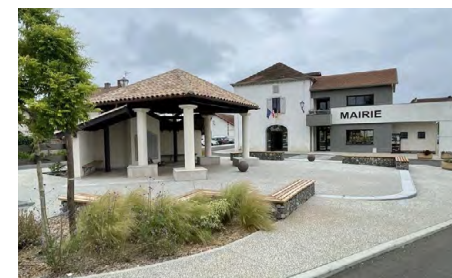
Travaux réalisés par la CCLO. © Bellocq
