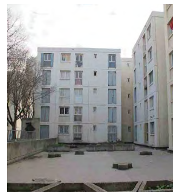
Vues des bâtiments existants.
