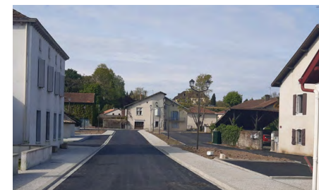
Travaux réalisés par la CCLO. © Bellocq
