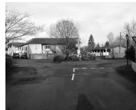
Etat avant travaux.
