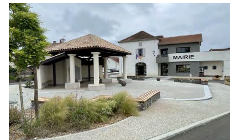
Travaux réalisés par la CCLO. © Bellocq
