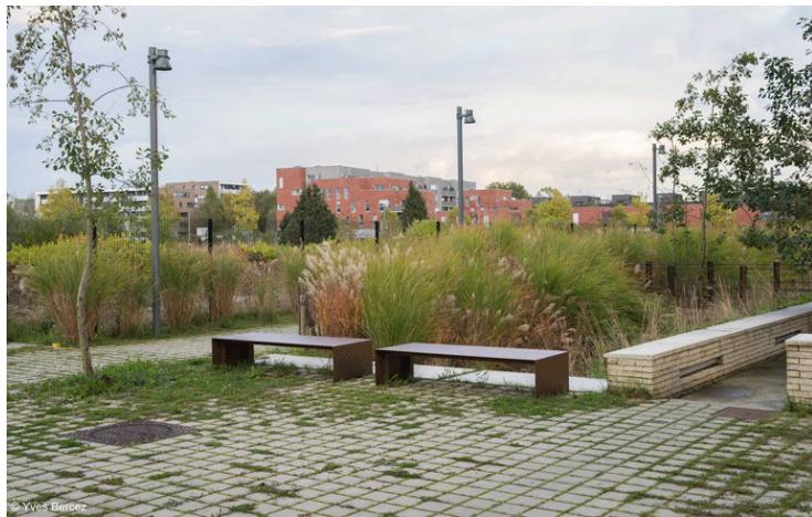
Pavés drainants enherbés.
