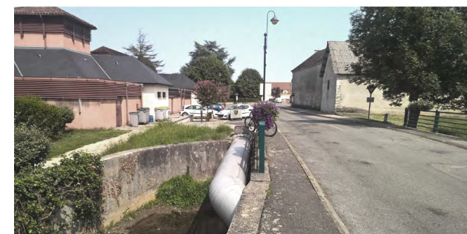
Vue de l'état existant.
